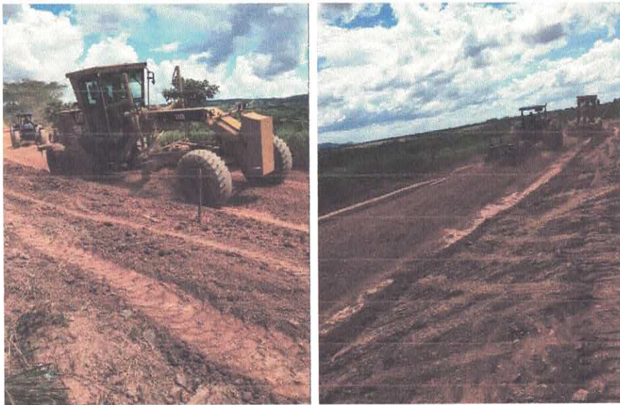
Figura 2 - Regularização do Sub-leito
