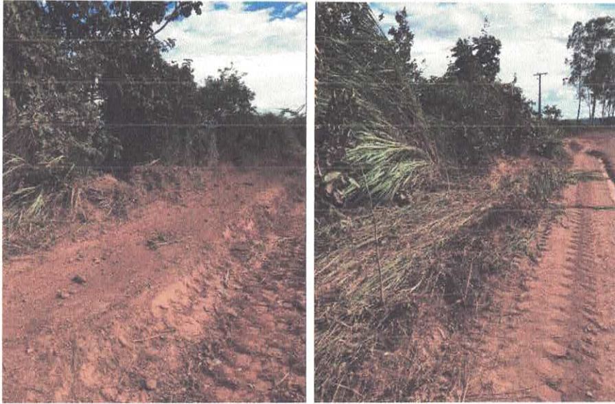
Figura 1 - Limpeza da área
