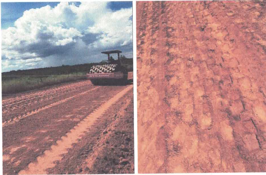
Figura 4 - Compactação do Sub-leito
