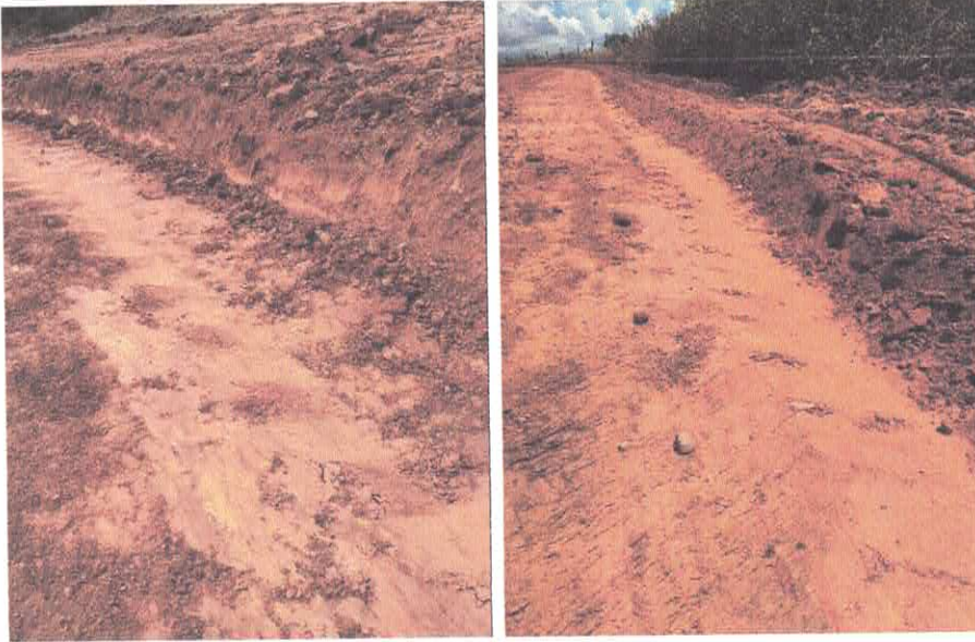
Figura 5 - Espessura de tratamento do Sub-leito
