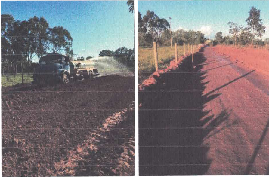
Figura 3 - Umedecimento do Sub-leito
